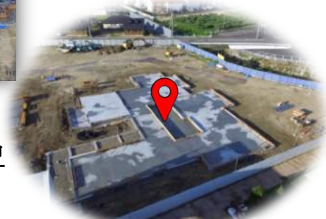
理科室建設中
