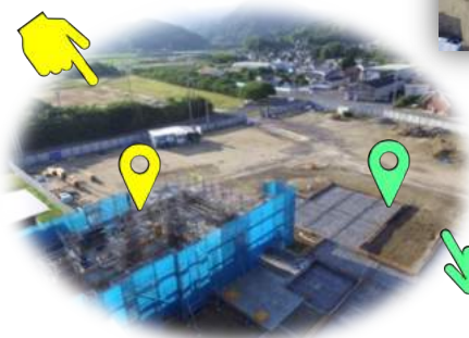
図書館建設中
