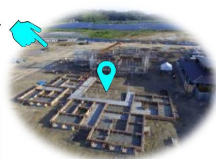
技術室建設中
